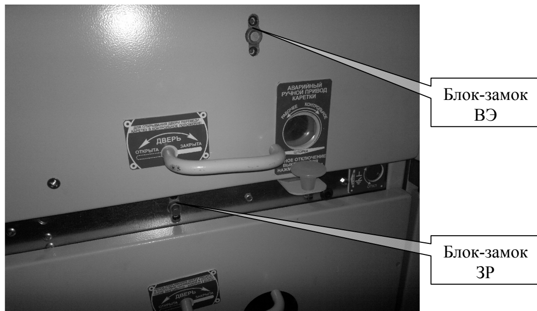
Рисунок 59 – Расположение электромагнитных блок-замков
